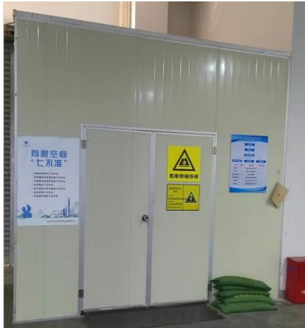
项目危废仓库
